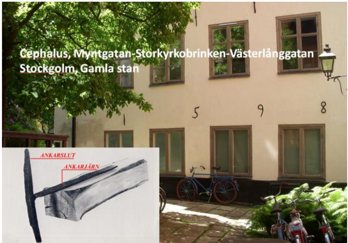
Figur 2. Ankarjärn med ankarslut i murverk i kv. Cephalus i Gamla stan i Stockholm.
